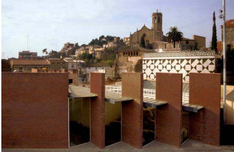
Fig. 3 Arriola&Fiol Arquitectes, Museo de las Termas Romanas, Sant Boi de Llobregat, 1998
