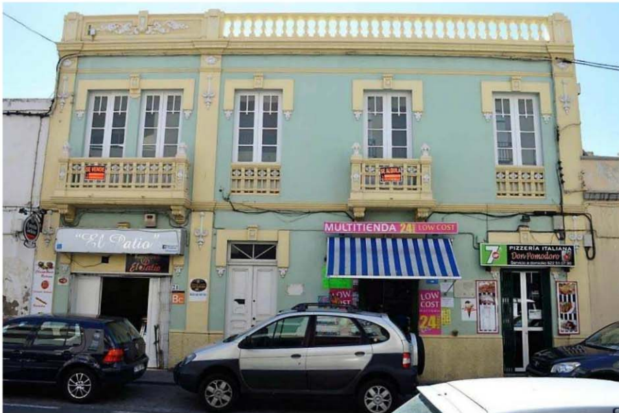
Fig. 3 Edificio Ecléctico nº 21 de la Avenida del Obispo Pérez Cáceres. Güímar
