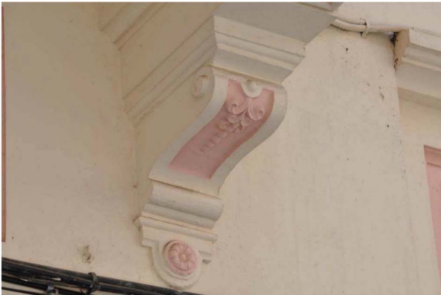
Fig. 9 Ménsula de balcón del edificio nº 57 de la calle del Castillo. Santa cruz de Tenerife
