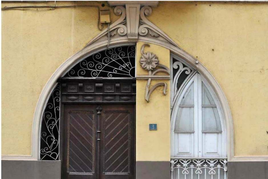
Fig. 7 Detalle de edificio Modernista nº 3 de la calle de la Rosa. Santa Cruz de Tenerife
