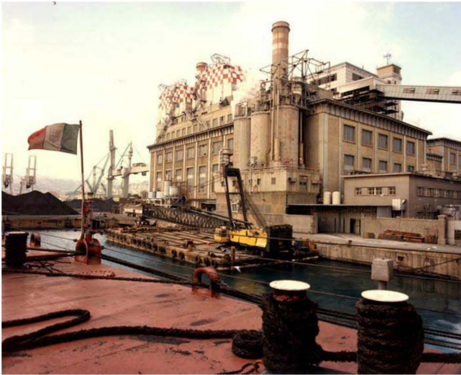
Fig. 9 Externo actual de la Central Eléctrica
