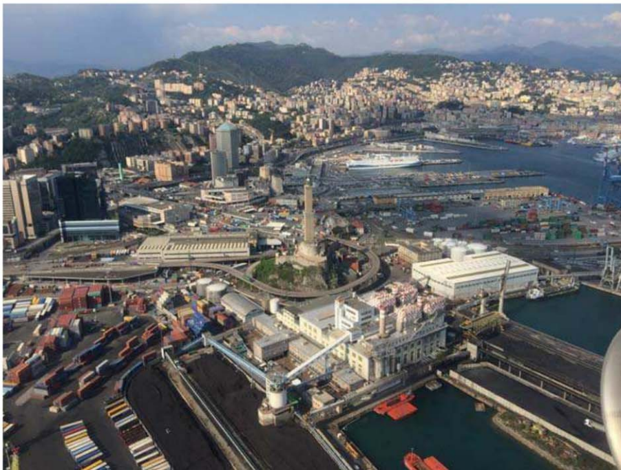
Fig. 8 Alrededores de la Central Eléctrica
