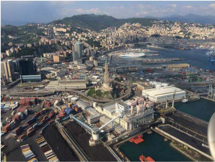
Fig. 8 Alrededores de la Central Eléctrica
