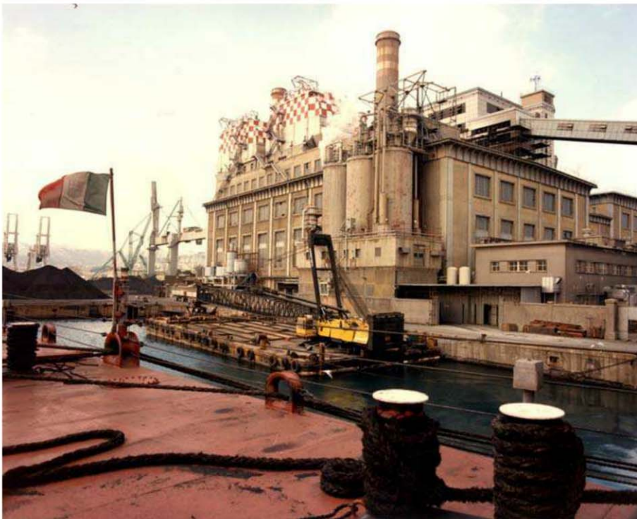
Fig. 9 Externo actual de la Central Eléctrica
