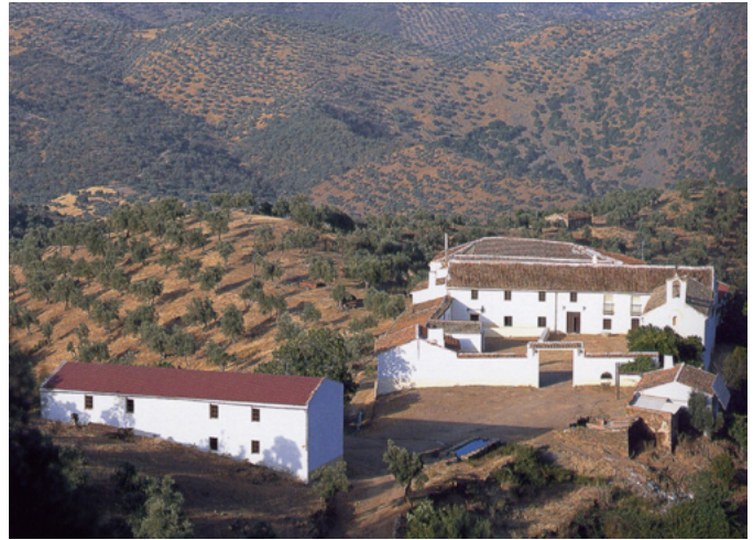
Pozoblanco. Cortijo de la Canaleja (izquierda) y cortijo de Pedrique (derecha) | fuente AA. VV., 2000
