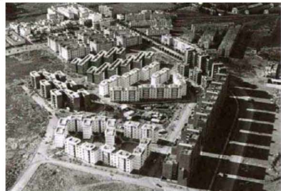
Fig. 4 Conjunto de Los Diez Mandamientos, 300 viviendas, 1958-1964. Edificios de 10 y 4 plantas
