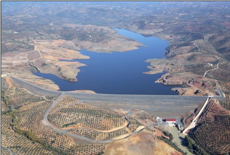
Ilustración 2-5. Presa y embalse del Arenoso
