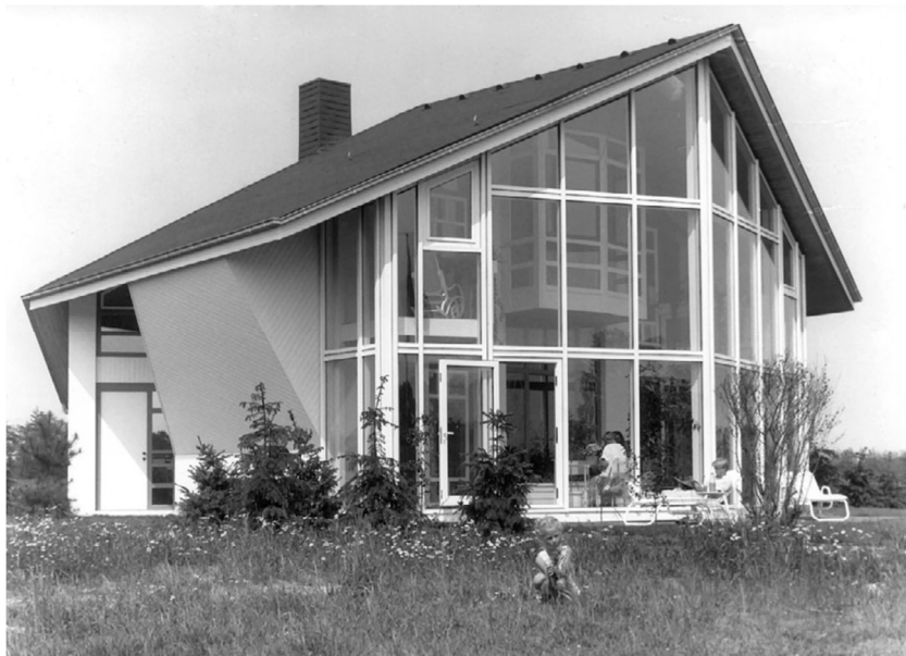
Figura 1.1. Vivienda con dobles fachadas acristaladas y correctamente orientada para conseguir el aprovechamiento pasivo de la energía solar
