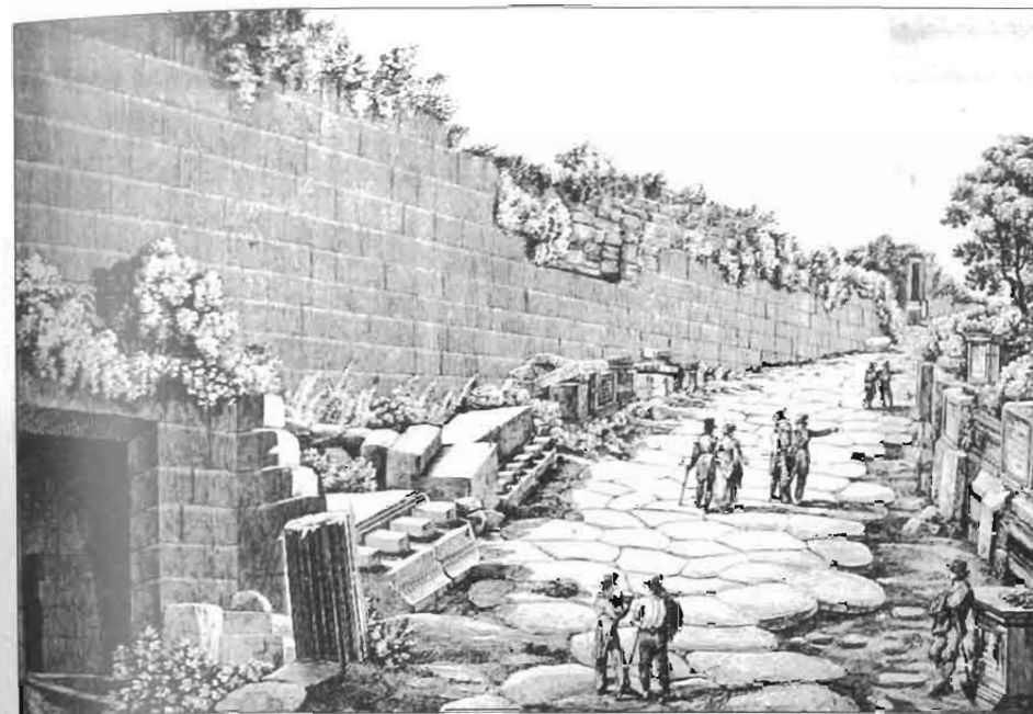
Fig. 2. L. Rossini, Le antichità dei contorni di Roma... , lám. LXXII: vista de la vía romana que unía Tusculum con la Labicana. En el lado izquierdo se ve la fuente de los ediles y la fuente etrusca y, en el margen derecho del camino, el material epigráfico que se había descubierto durante las excavaciones de Luciano Bonaparte.
