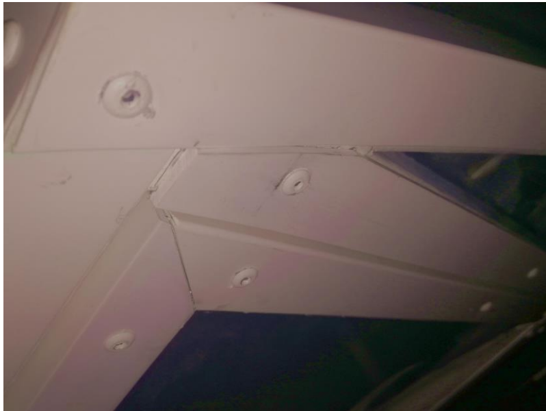
Sujecion remachada de la cubierta de PVC rígido con tiras de plástico de cobertura
