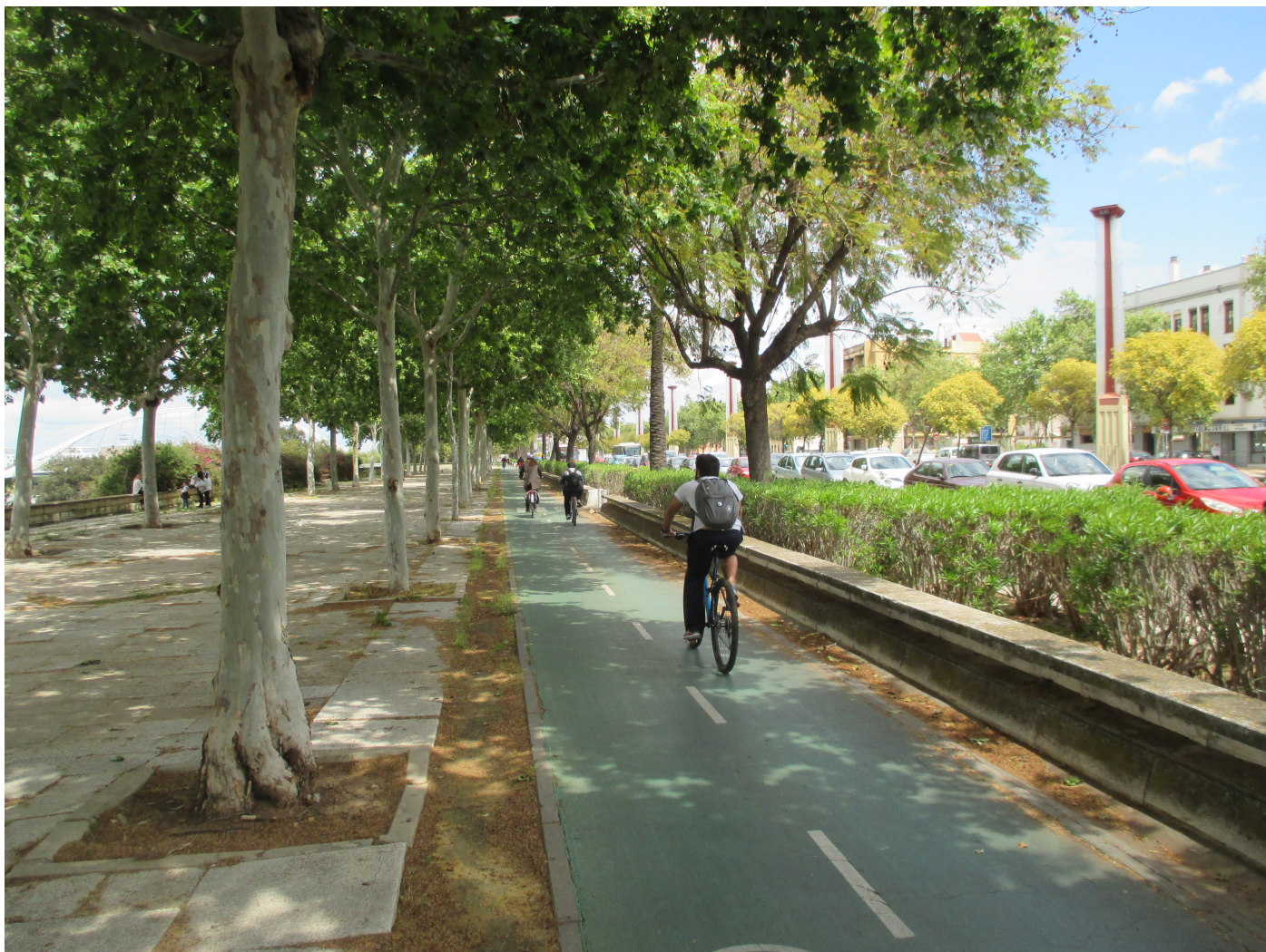
Figura 4. Vía ciclista realizada sobre acerado preexistente a lo largo de la calle Torneo (Itinerario II). Fuente: Elaboración propia.
