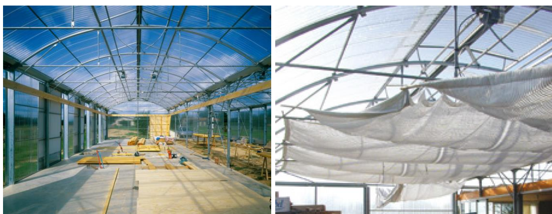
De izquierda a derecha, estructura del edificio durante el proceso de construcción (7) y con protección solar (8).
