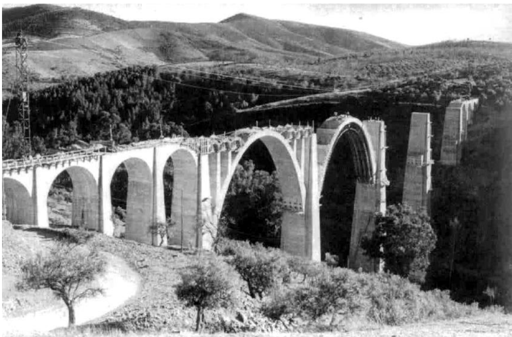
Fotografía de la construcción del Viaducto, 1958
