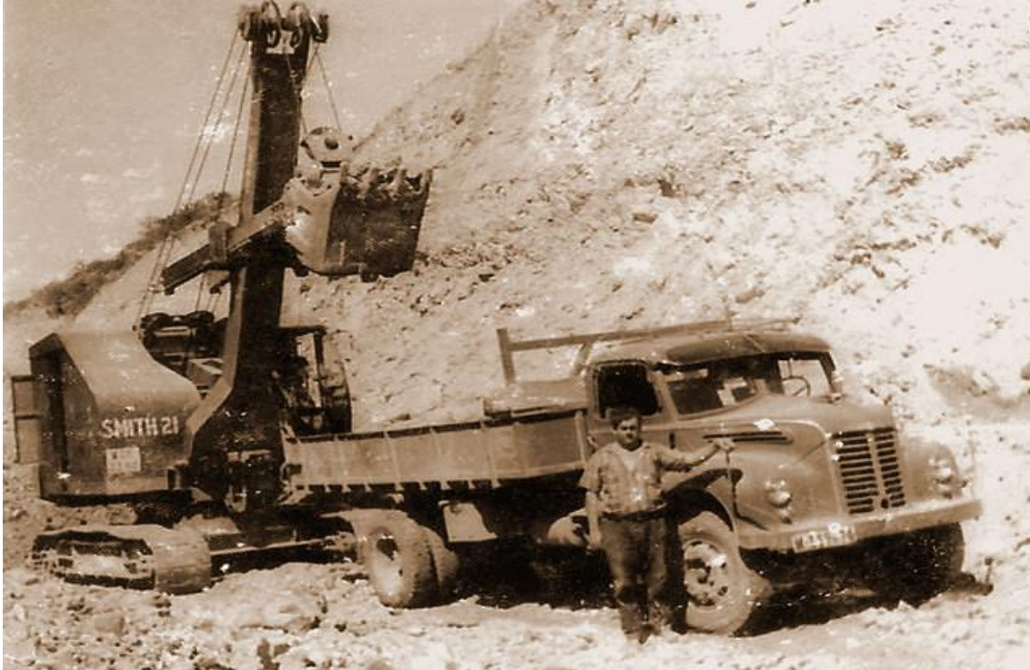
Personal de la época trabajando en la excavación de una trinchera antesala de uno de los túneles
