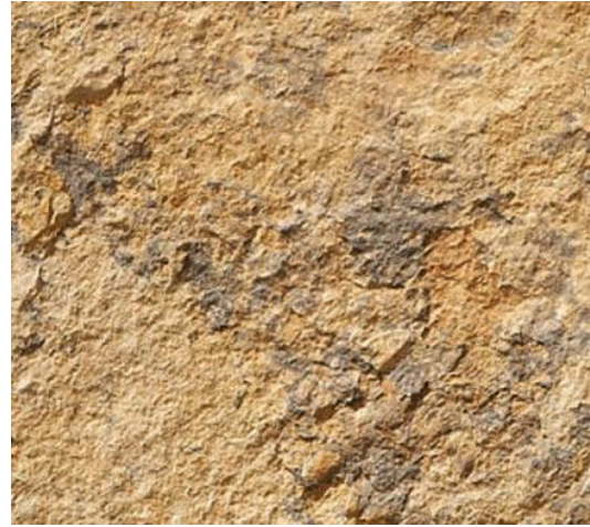
Piedra pizarra de la fachada
