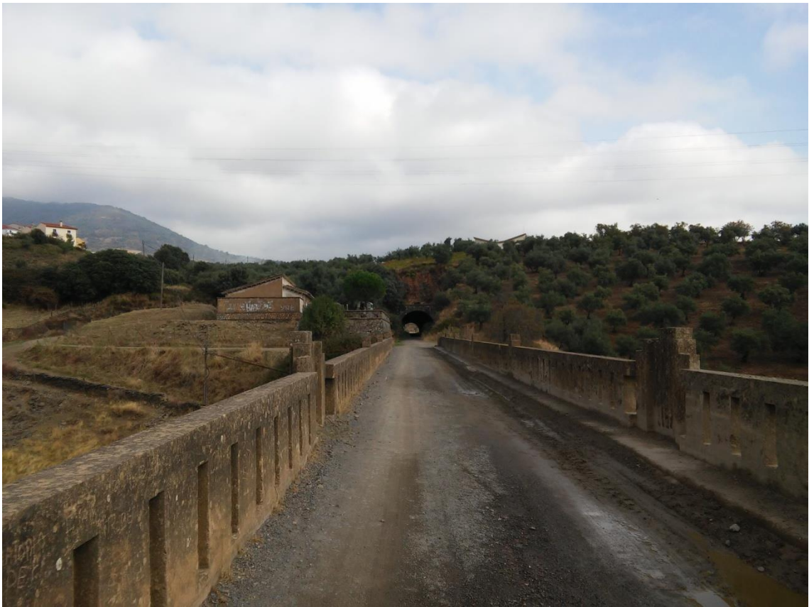
Fotografía desde el Viaducto, al fondo el túnel
