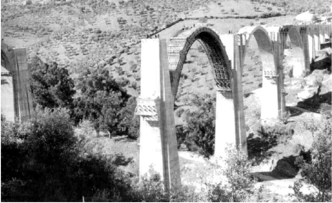
Fotografía de la construcción del Viaducto, 1958
