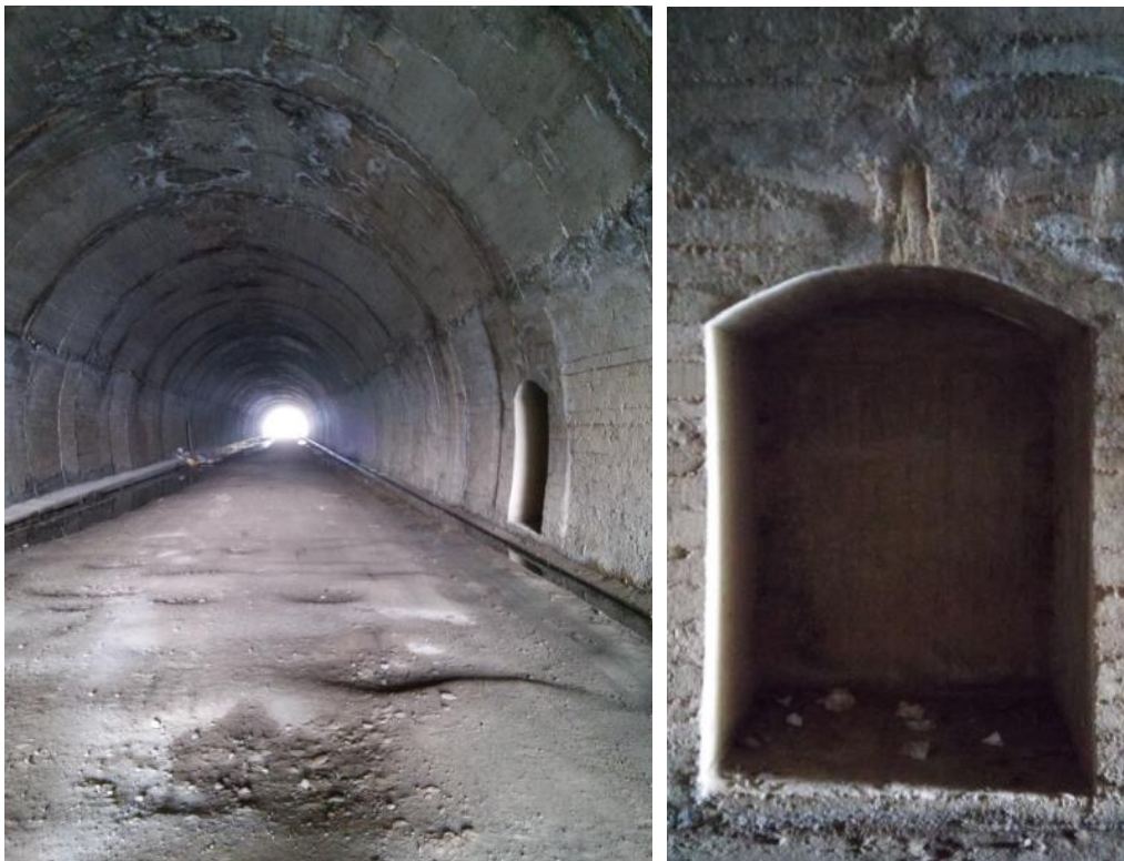
Fotografía del interior del túnel con las escapatorias para refugio de las personas cuando pasara el ferrocarril.
