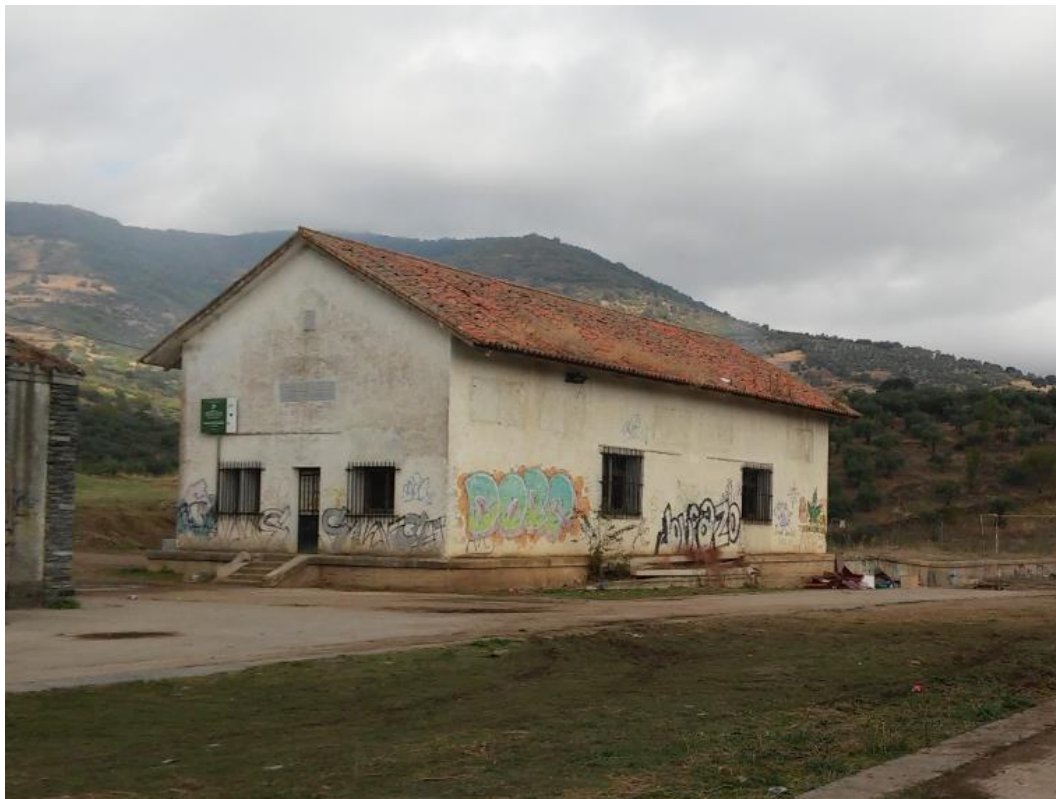
Fotografía del edificio de almacén
