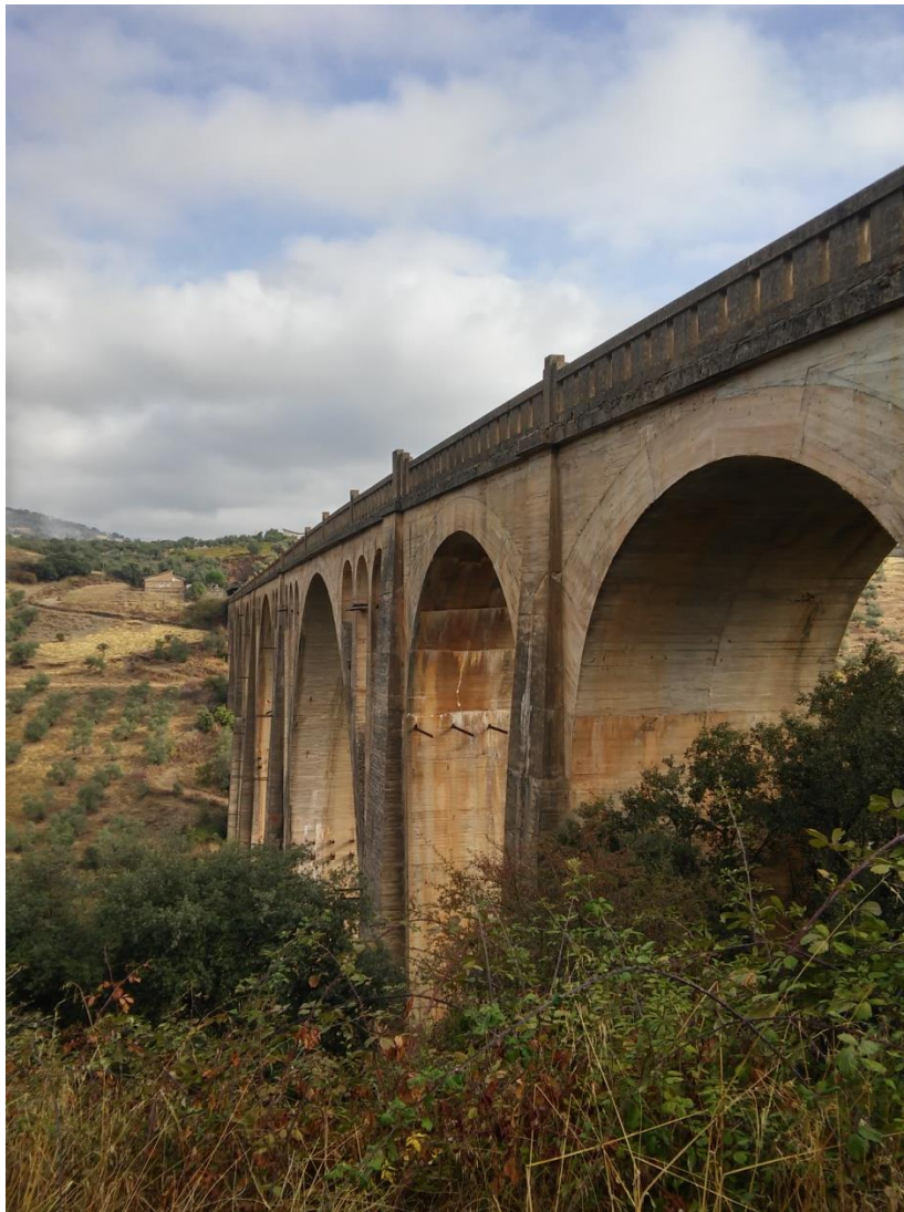
Fotografía desde el exterior del Viaducto
