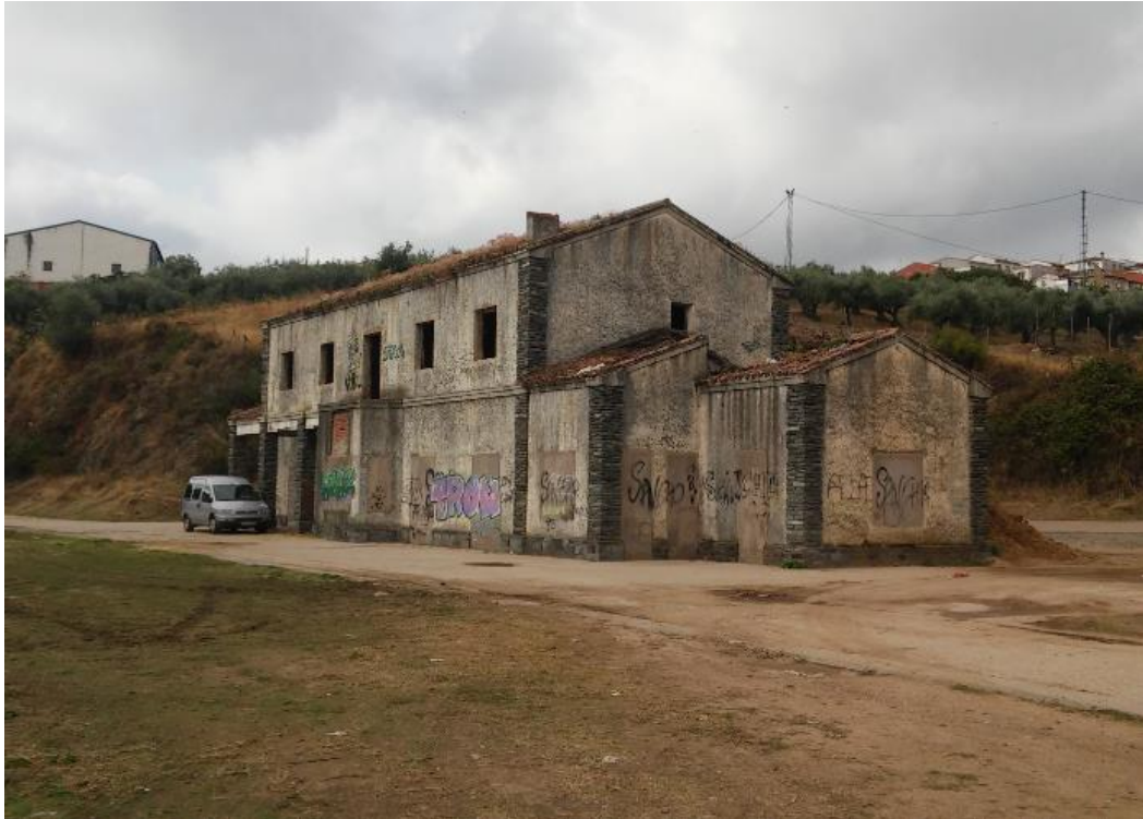
Fotografía del edificio de la Estación
