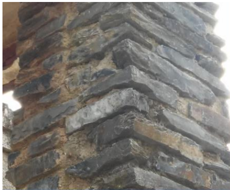
Pilastra de pizarra de la Estación de Guadalupe
