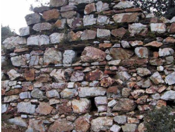
Mampostería de cuarcita del Pozo de las Nieves
