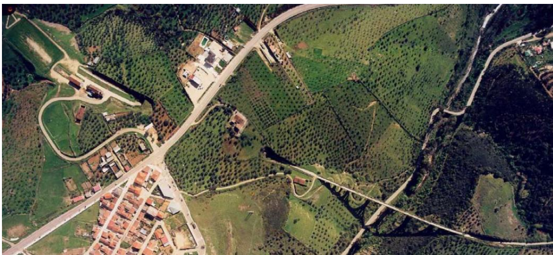
Ortofoto del conjunto de infraestructuras del ferrocarril en Guadalupe
