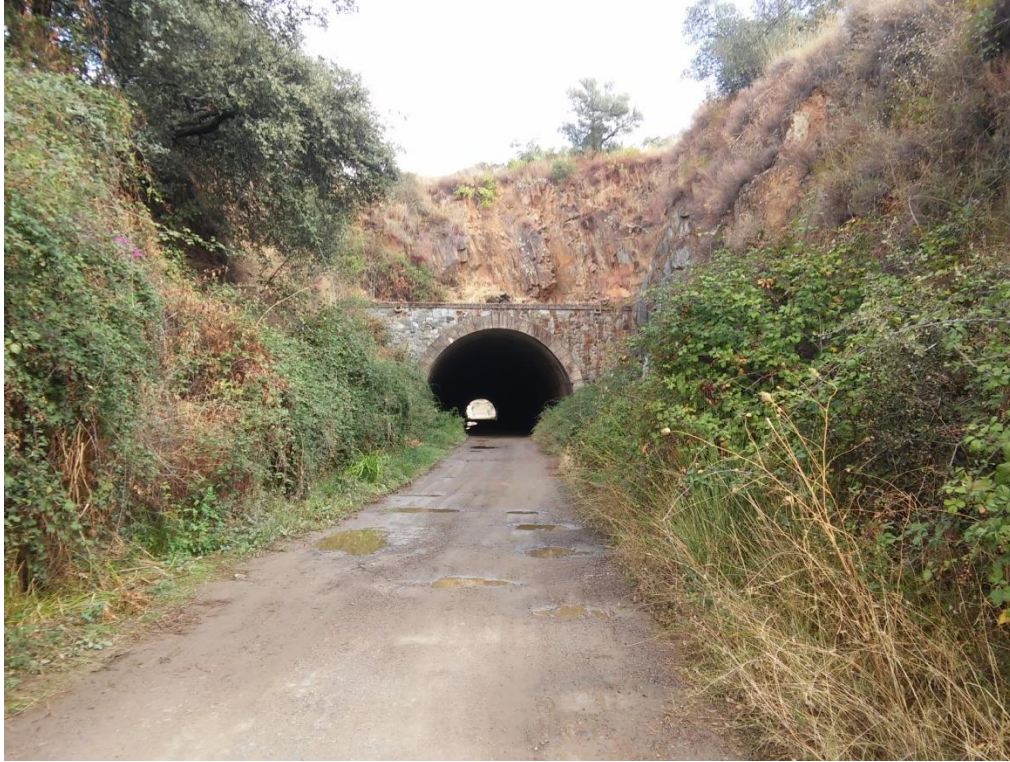
Fotografía de la entrada del Túnel, dirección Guadalupe.
