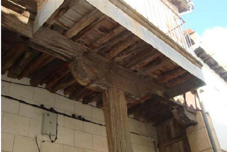
Entramado de madera y sujeción de uno de los soportales
