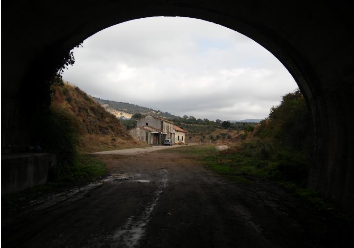
Fotografía de la salida del Túnel, dirección Guadalupe, desde el interior con la estación al fondo.
