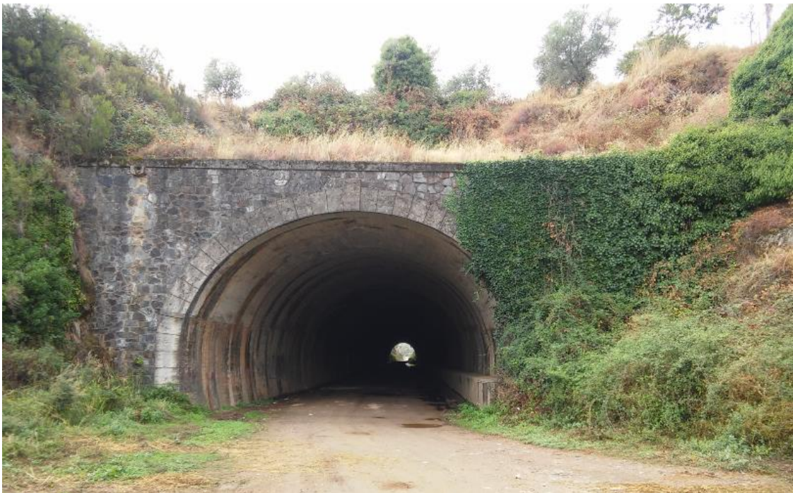
Fotografía de la salida del Túnel, dirección Guadalupe.
