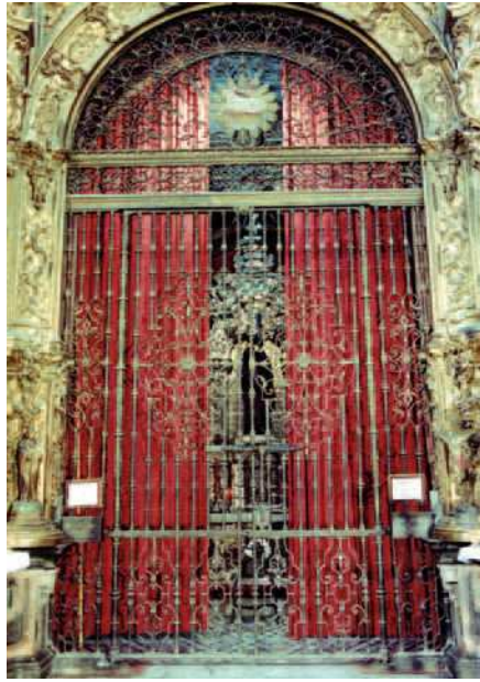
9. Obra anónima sevillana. Reja de acceso a la capilla sacramental del Salvador. 1752.
