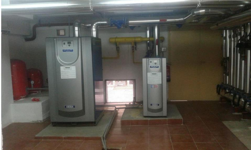
*Figura 10. Generadores de vapor de la sala de máquinas.*
