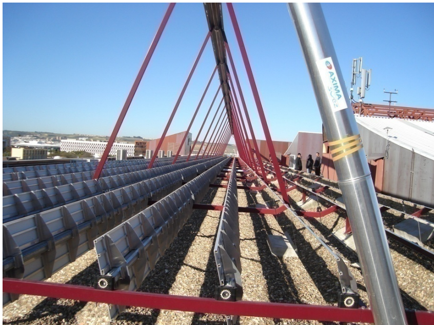
Figura 4-3 Estructura de acero del colector solar
