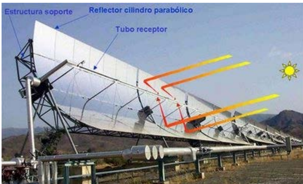
Figura 3-6 Colector cilindro parabólico
