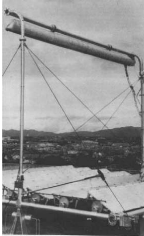
Figura 3-7 Colector Fresnel construido por Giorgio Francia, 1968
