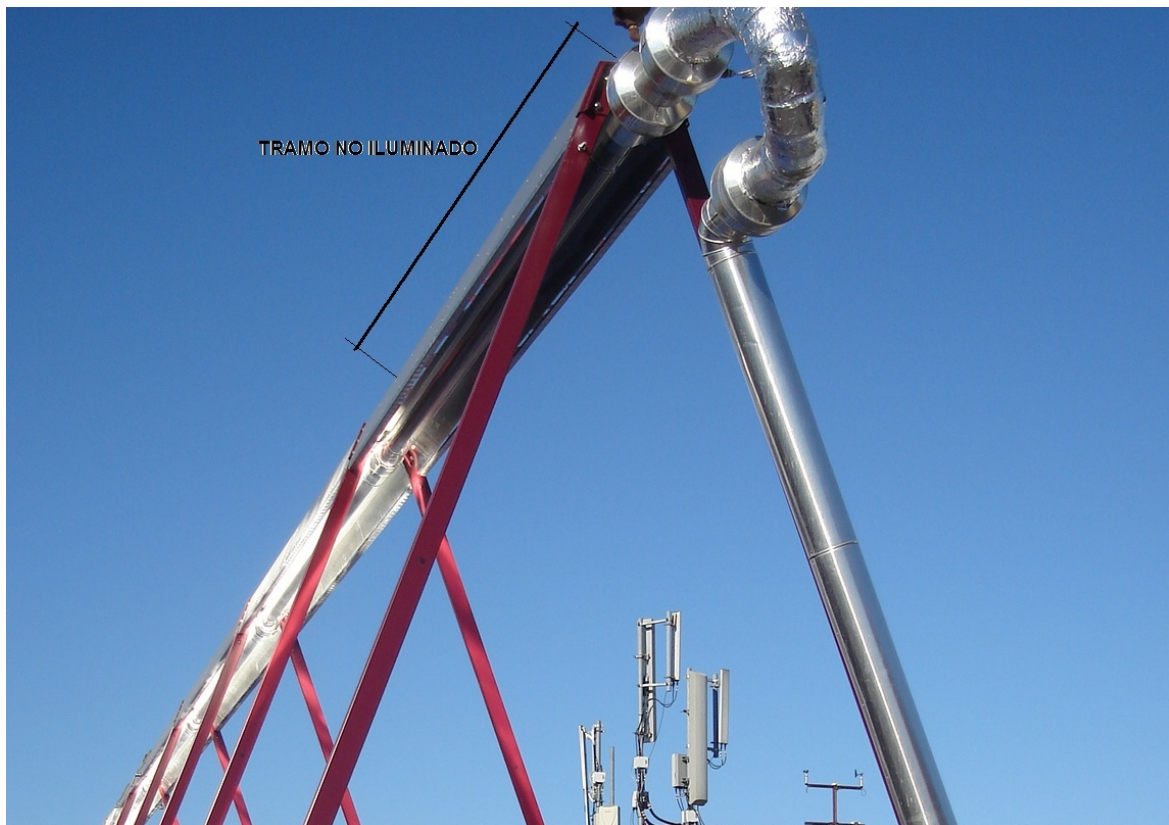
Figura 5-17 Tramo de tubo no iluminado debido al azimut solar
