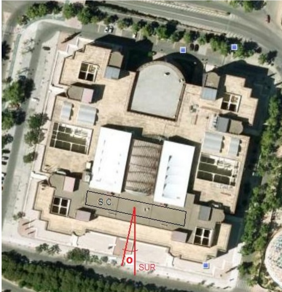
Figura 4-1 Vista aérea de la cubierta
