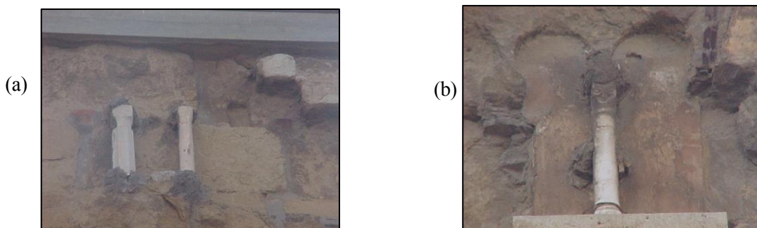
Figuras 2.8 (a) Friso de la fachada NO y (b) Friso de la fachada NE del alminar
