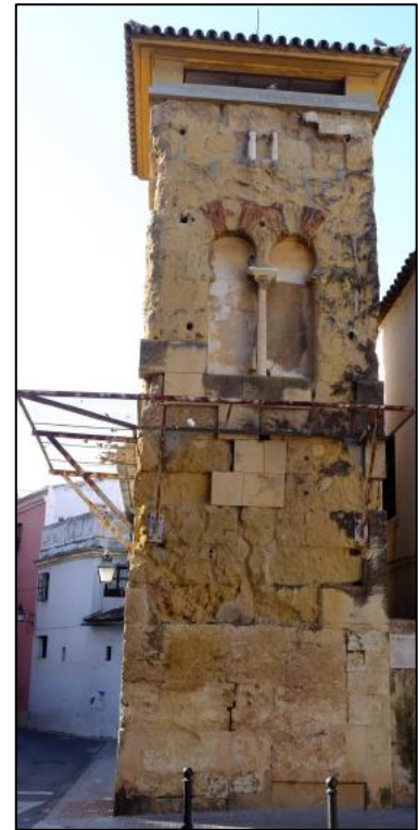
Figura 2.1 Fachada noroeste del Alminar de San Juan de los Caballeros
