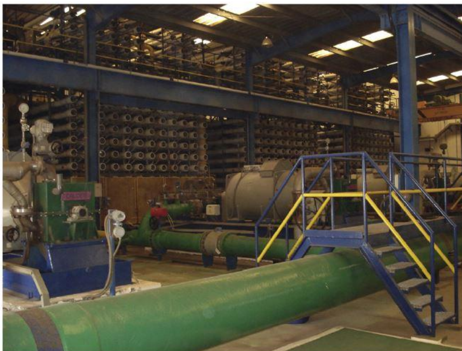
Figura 4.1: Trenes RO de la planta Lanzarote IV. Fuente: Science Direct, Desalination.
