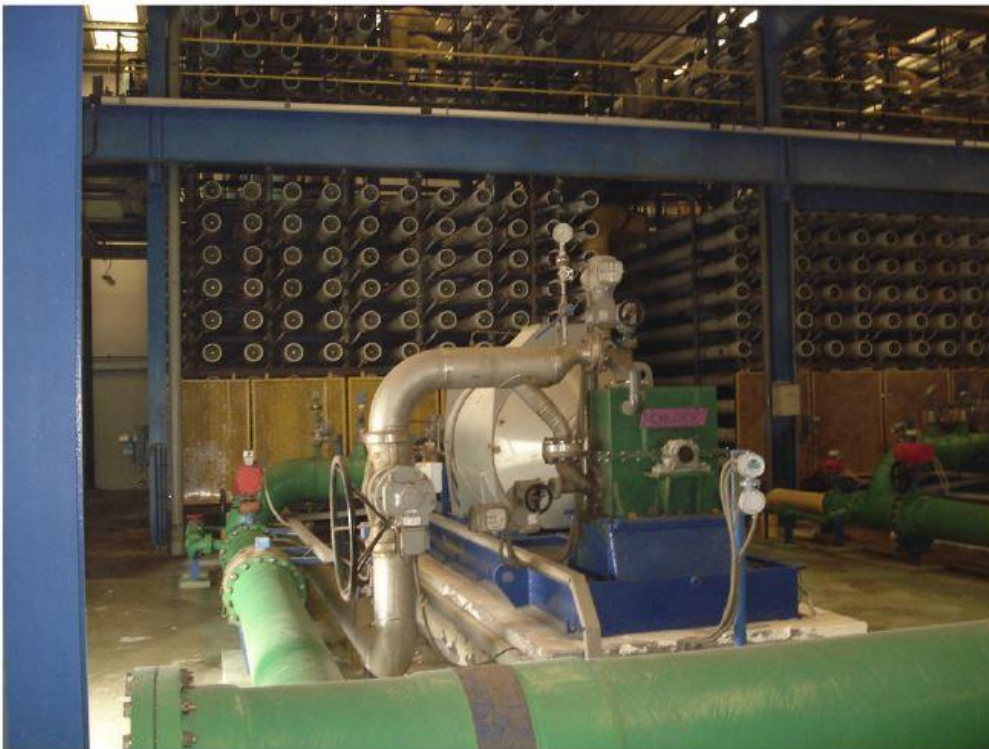
Figura 4.3: Detalle rueda turbina Pelton de la planta Lanzarote IV. Fuente: Inalsa
