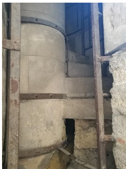
Figura 3. Núcleo y escalera en el interior del alminar
