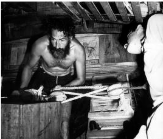
Ilustración 17 Carlos Etayo Elizondo construyendo la Niña II
