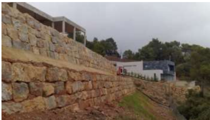
Figura 19. Muro de contención de piedra. (Fuente ICA Ingenieros)
