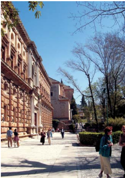
Figura 2. Fachada sur del palacio.
