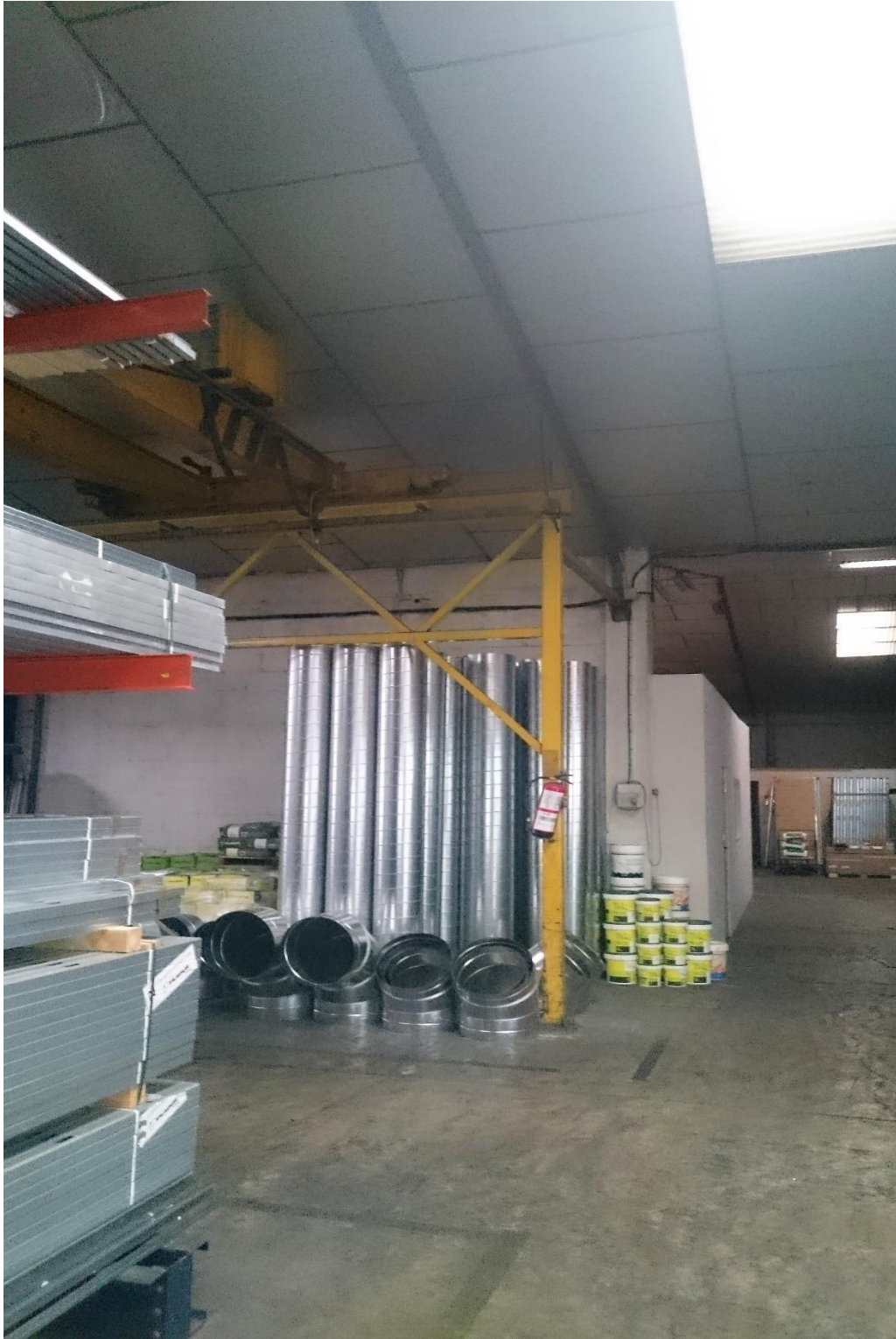
Figura 6: Instalación puente grúa.
