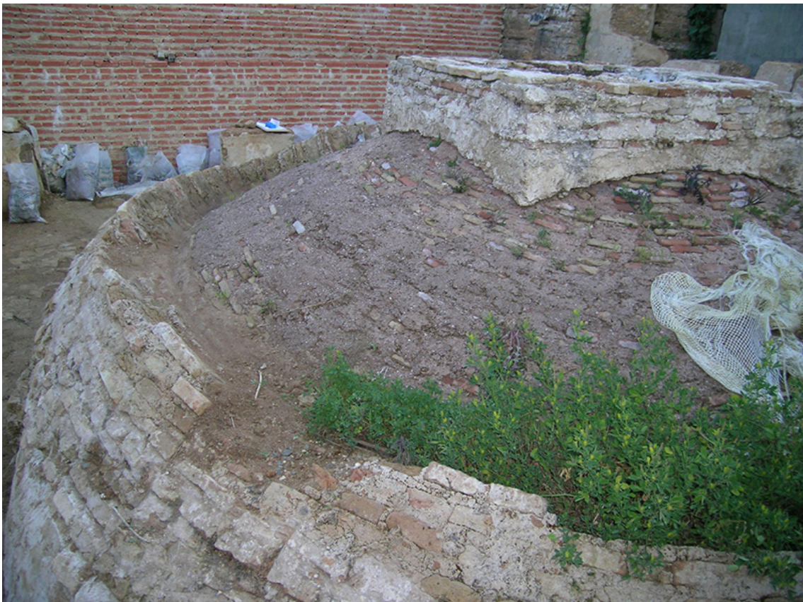
Link 06. Tratamiento de la torre Suroeste. Limpieza de plantas superiores y colmataciones.
