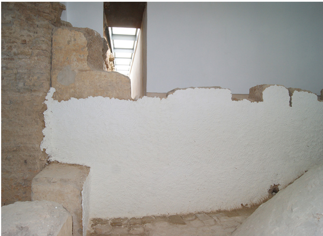
Link 08. Tratamiento de la torre Suroeste. Operación de desalinización con pulpa de papel.
