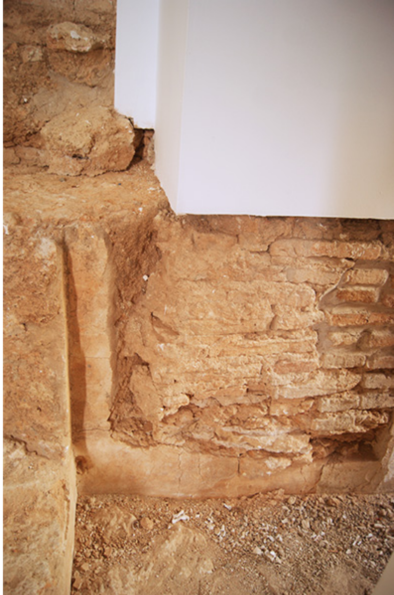
Ilustración 01. Merlatura del lienzo Oeste del Castillo de San Romualdo. Detalle del merlón esquinero.
