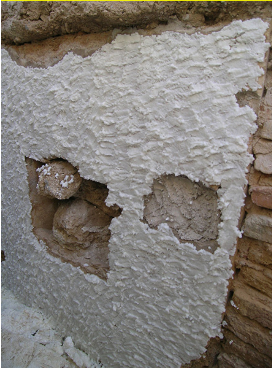
Link 09. Tratamiento de la merlatura occidental. Operación de desalinización con pulpa de papel.
