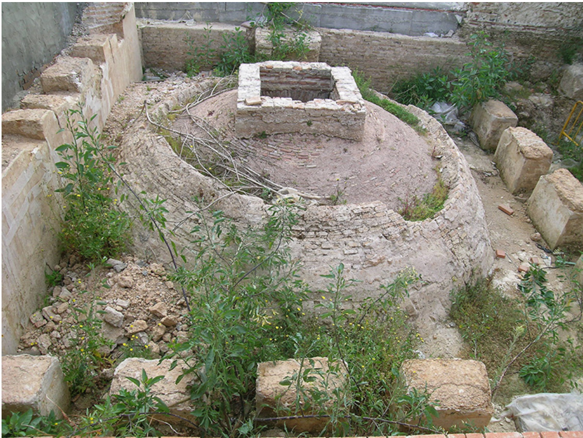
Ilustración 05. Estado de conservación de la torre Suroeste del Castillo de San Romualdo antes de la intervención.
