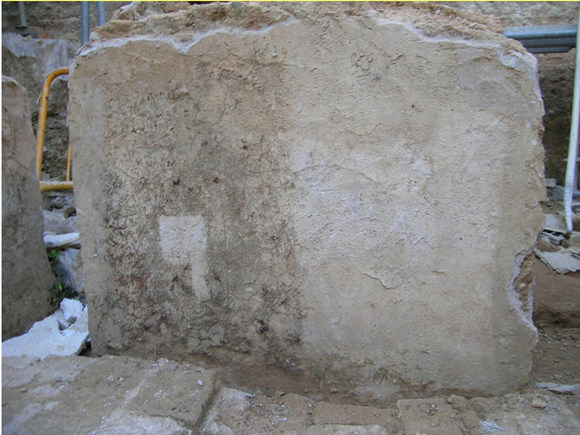
Link 07. Tratamiento de la torre Suroeste. Proceso de limpieza química.
