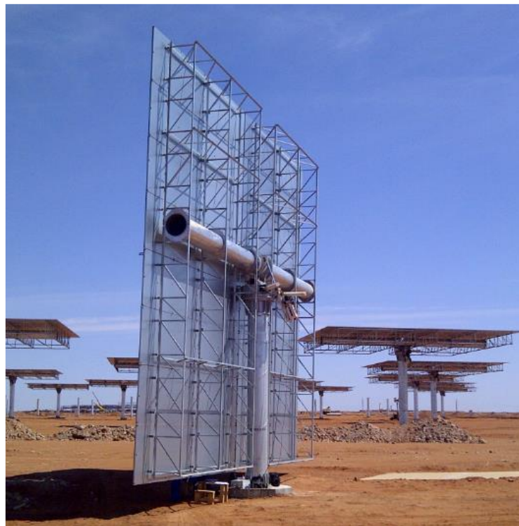
Ilustración 18 Helióstato de Khi Solar One
