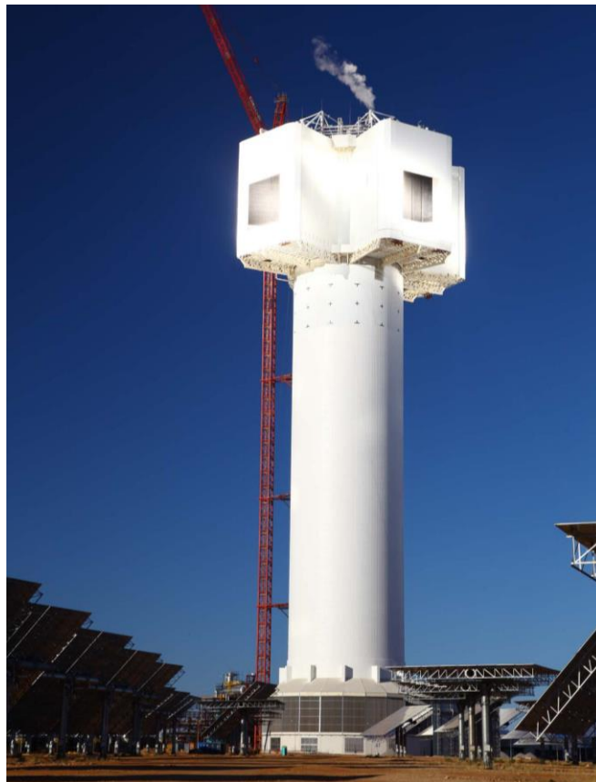
Ilustración 19 Receptor y torre Khi Solar One
