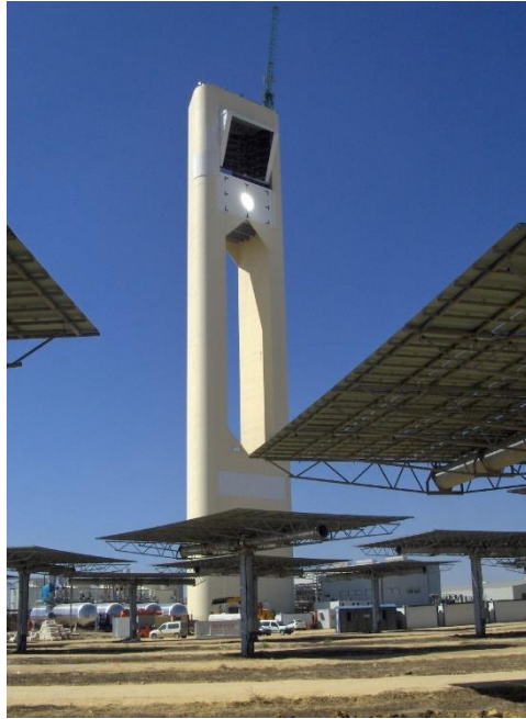
Ilustración 8 Receptor de la PS-10
