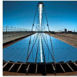
Concentrador Lineal de Fresnel
