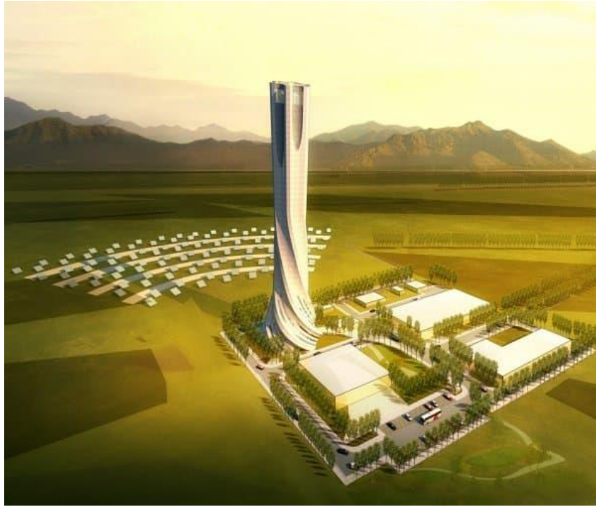
Ilustración 22 Planta solar Yanking (Beijing)
