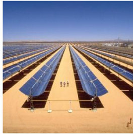
Colectores Cilindro Parabólicos o CCP
