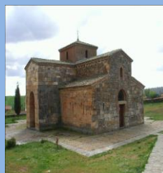
Se distinguen las distintas alturas de la nave central y las naves laterales.
