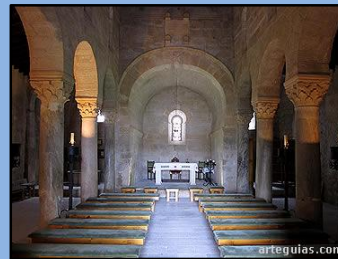
La cubierta se apoya en arcos de herradura, que sirve de marco a la capilla mayor.
