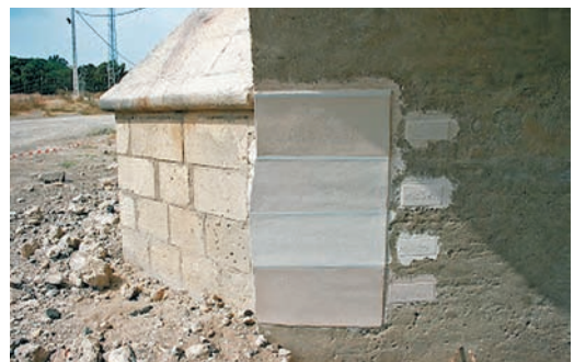
Figura 2. Puente de la Cartuja (s. XVI). Jerez de la frontera (Cádiz). Pruebas de mortero de revestimiento que enmascararán todos los indicativos visuales que lo identifican como un objeto perteneciente al pasado.
