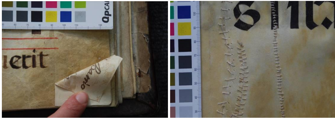
Fig. 4 y Fig. 5. Enmiendas históricas por uso; a la izquierda podemos ver un parche realizado a partir de documento manuscrito en papel y a la derecha distintos cosidos. Colección de libros de coro del Palacio de Viana (Córdoba).
