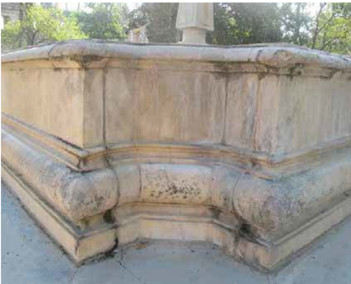
Figura 7. A la izquierda, daños de tipo químico por la formación de gruesos estratos de concreciones de tipo salino que recubren la superficie del soporte mármreo
