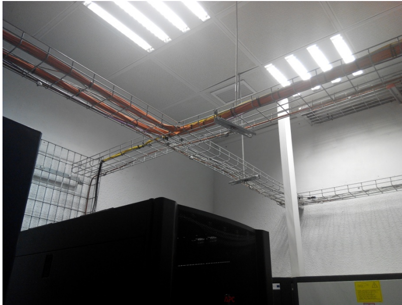
Ilustración 4-1. Bandejas por techo [1]
