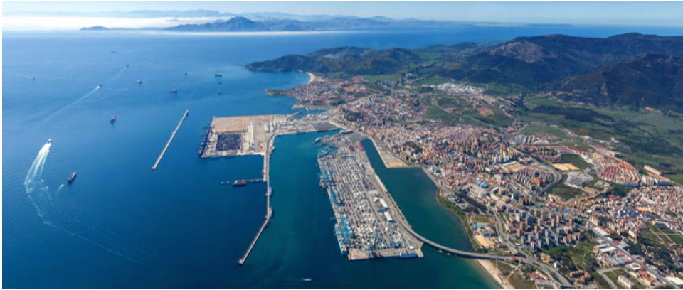
Ilustración 2-5 Vista aérea del Puerto de Algeciras [2].
