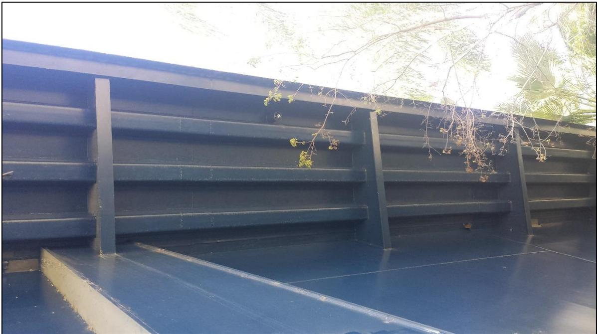
Ilustración 51: vigas longitudinales superiores y marcos rigidizadores
