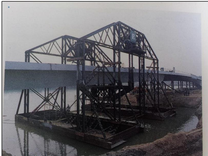
*Ilustración 64: elementos de flotación y elevación*
