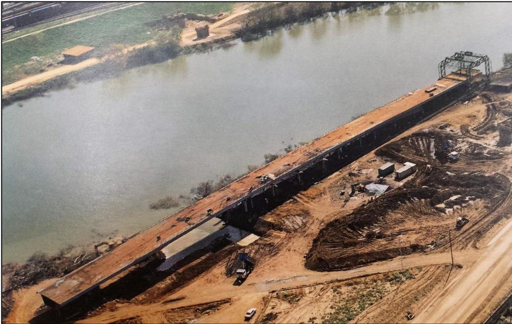
*Ilustración 59: Excavación de dársena*
