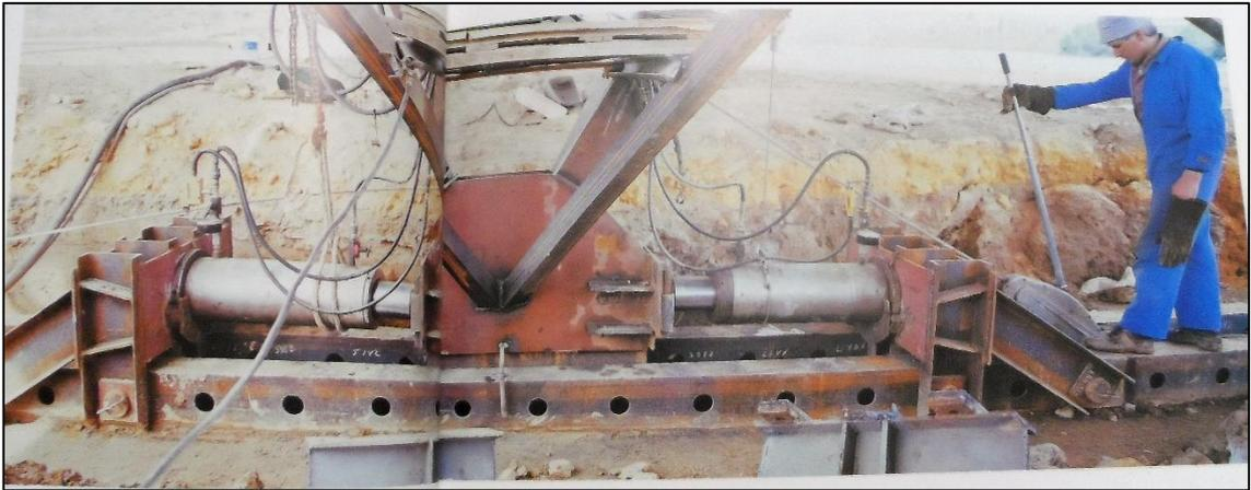
*Ilustración 67: detalle gato hidráulico*
