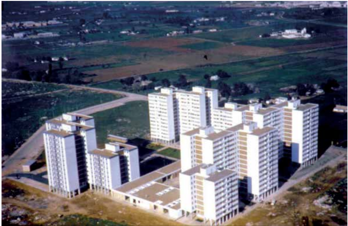
Figura n° 2. Fotografía. Construcción del barrio de San Diego (1972).
