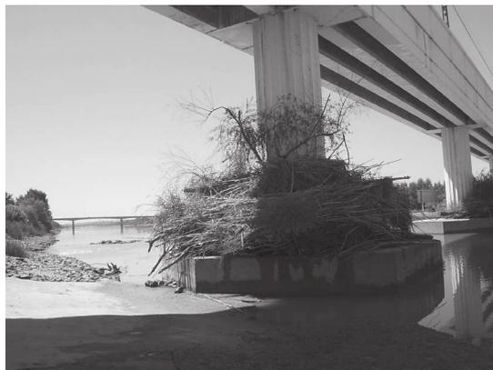
*Figura 3: Exhumación de las bases de las pilas en el puente del ferrocarril sobre el río Guadalquivir*
