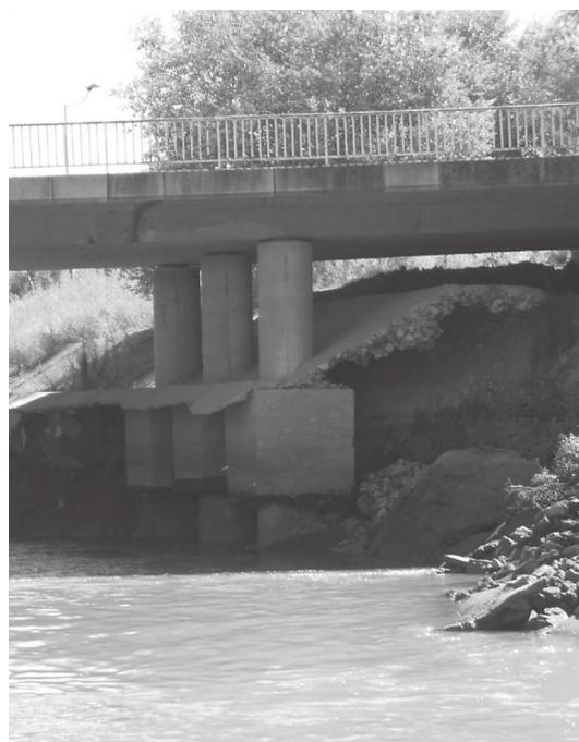
*Figura 4: Exhumación de las bases y pilotes en el puente de paso sobre la confluencia del Tamarguillo y el río Guadalquivir*
