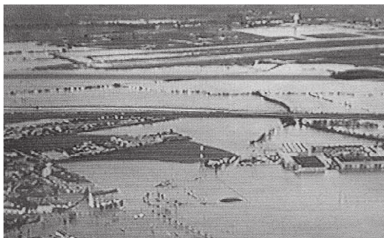
Fig. 5. Extensión de la lámina desbordada en las inmediaciones del centro comercial
