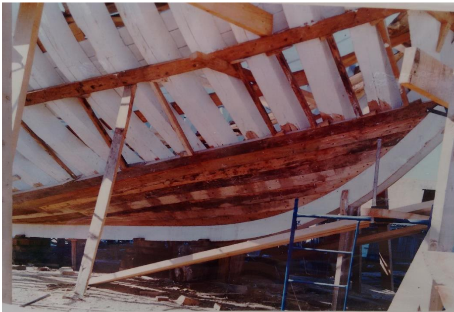
Figura 6.32. Detalle de la construcción del casco
