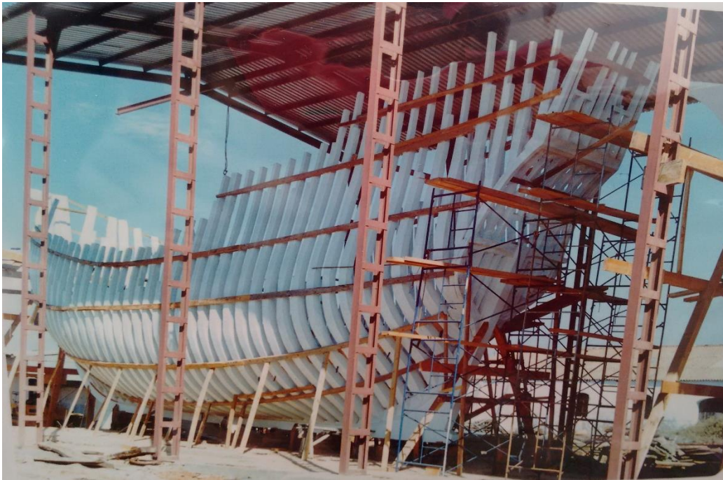
Figura 6.19. Estructura interna vista desde popa
