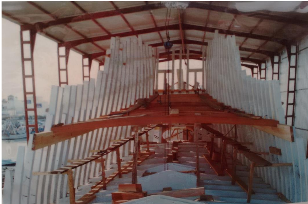
Figura 6.38. Fabricación de la cubierta
