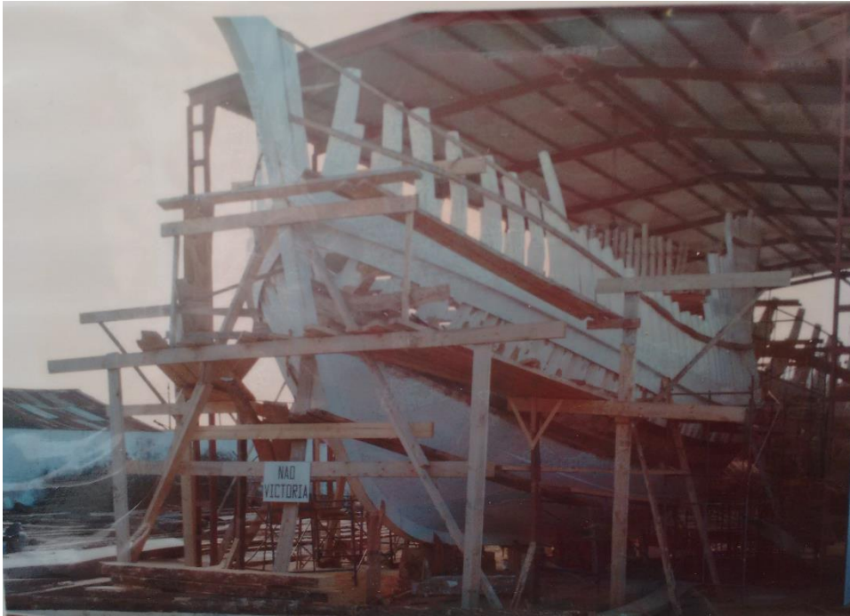
Figura 6.31. Construcción del casco
