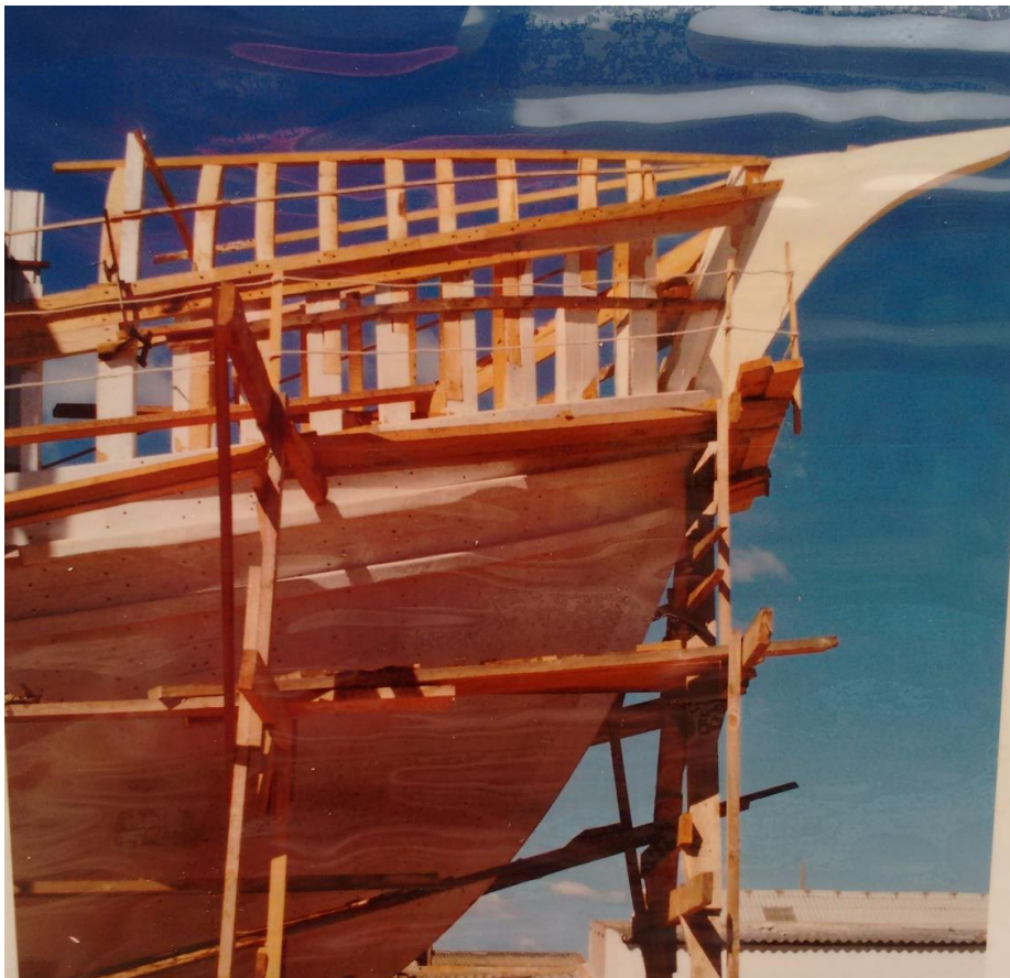
Figura 6.48. Construcción de la base del castillo
