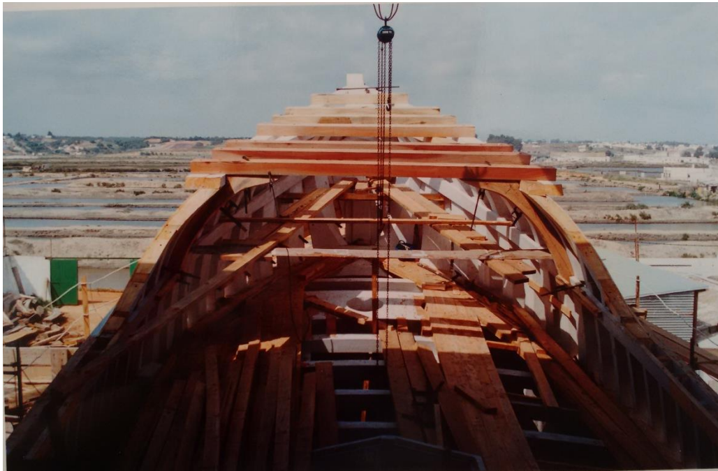
Figura 6.49. Colocación del suelo del castillo
