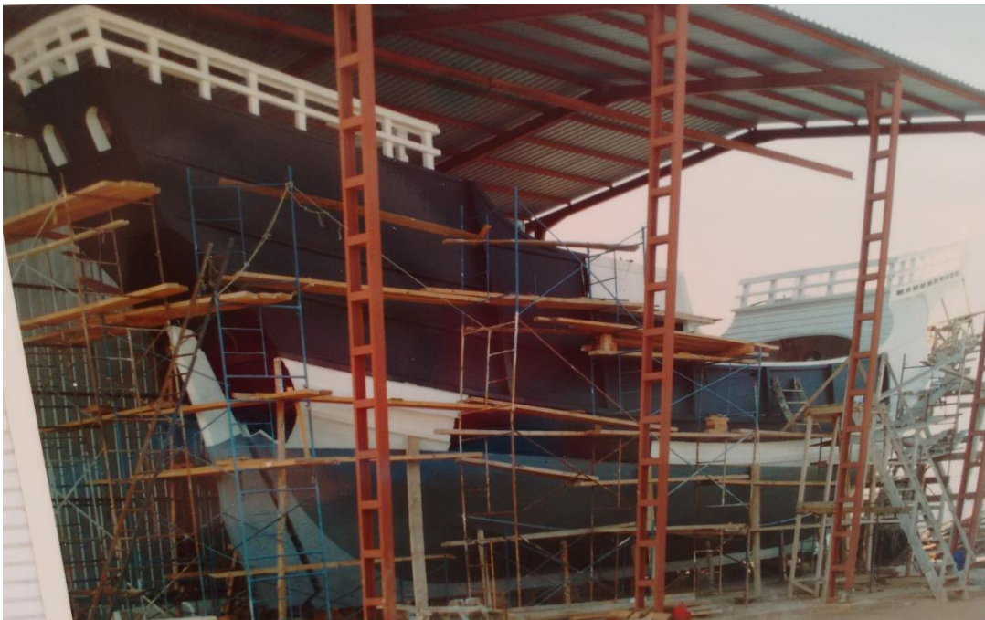
Figura 6.56. Reconstrucción con las barandillas
