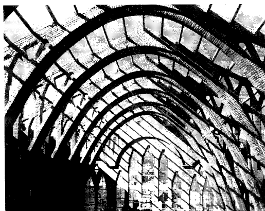
Figura 17 El intradós de los arcos delimita visualmente el espacio interior. Los planos de la cubierta lo encerrarán. Bodega de Pinell de Brai. César Martinell (1918-1921).
