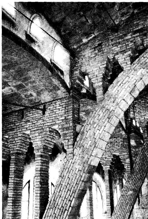
Figura 13 El número de hiladas aumenta con la carga. Bodega de Gandesa. César Martinell (1919-1920).
