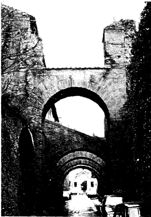
Figura 5 Arcos de acodamiento de la iglesia de San Giovanni e Paolo. Clivo di Scaurio, Roma.
