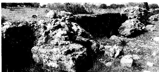
Figura 2 Restos de la presa de Las Muelas
