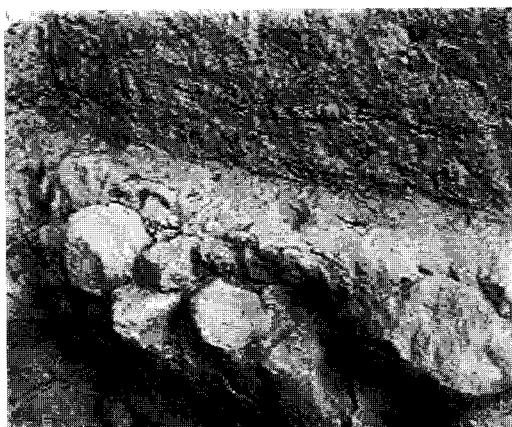
Figura 4 Cimentación bajo muro
