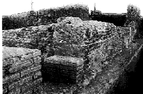
Figura 7 Junta central en muro
