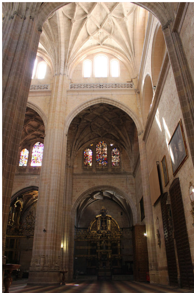
Figura 2. Catedral de Segovia. Tramo formado por nave central, laterales y capillas hornacinas.
