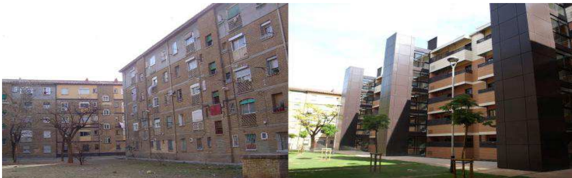
Fig. 4 "Edificio antes y después de la rehabilitación". Fuente: S.M.R.U.Z.
