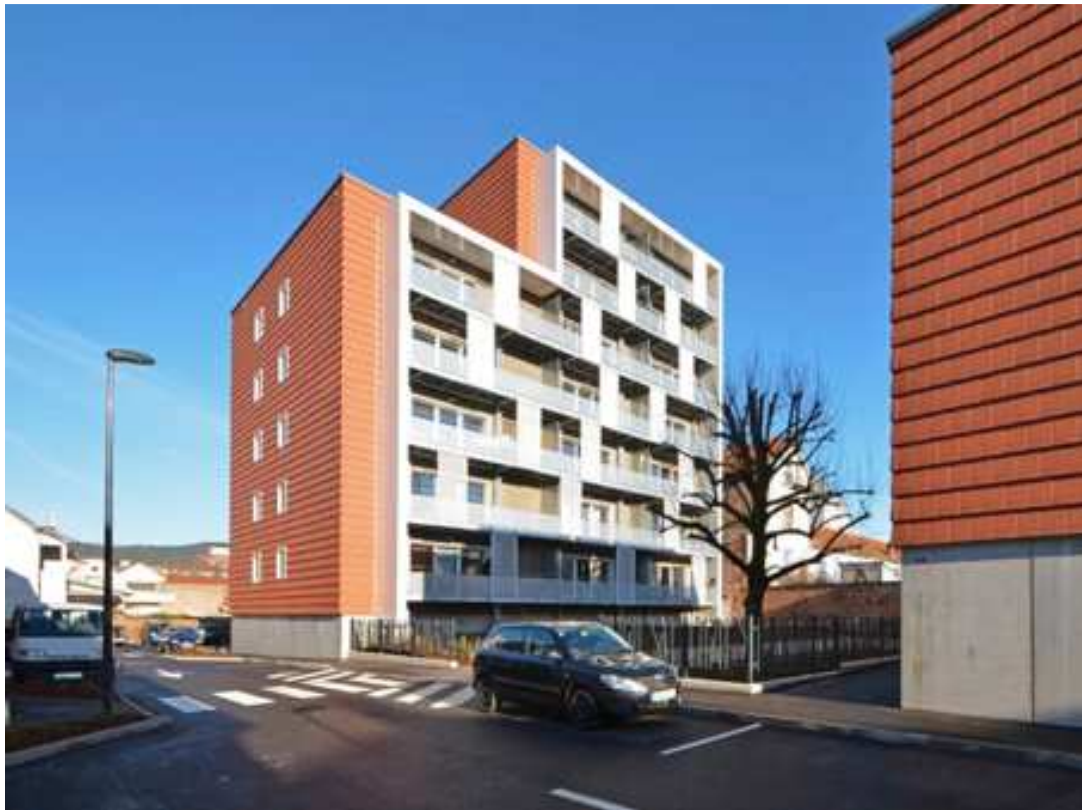
Fig.6 "Residence Jules Ferry, France built with straw bales, passivhaus, 7 stories." Source: http://www.toit-vosgien.com/fr/performances-energetiques/immeuble-bois-grande-hauteur.html
