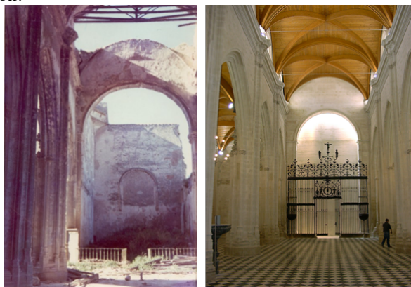
Fig. 4 Recuperación simbólica del espacio del antiguo Coro, perdido en la Guerra Civil. Izquierda la realidad física y dimensional destruida, Derecha el espacio evocado sin la auténtica realidad dimensional.
