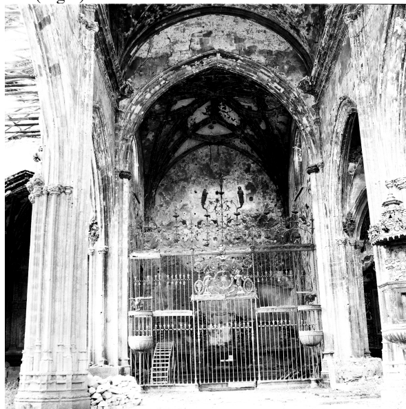
Fig. 6 Estado tras el incendio y destrucción en la Guerra Civil 1936-39. Foto de Carmelo Ruiz
