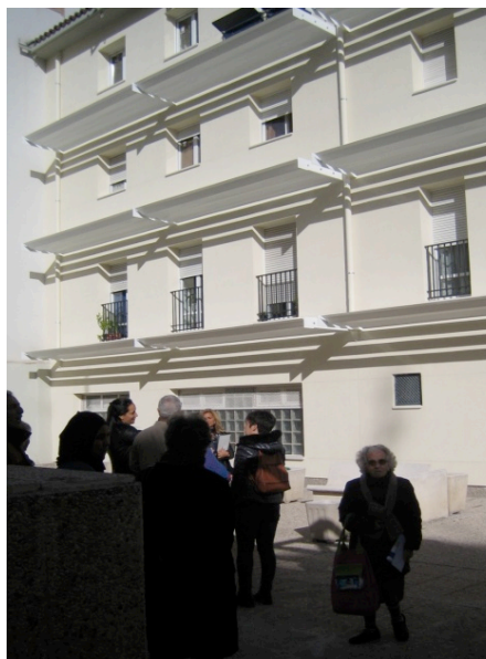
Fig. 4 Fachada sur después de la intervención. Mañana de diciembre
