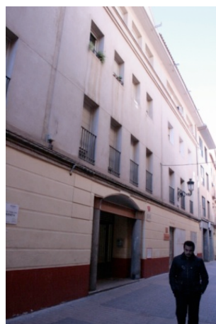
Fig. 2 Fachada norte del edificio a calle San Pablo
