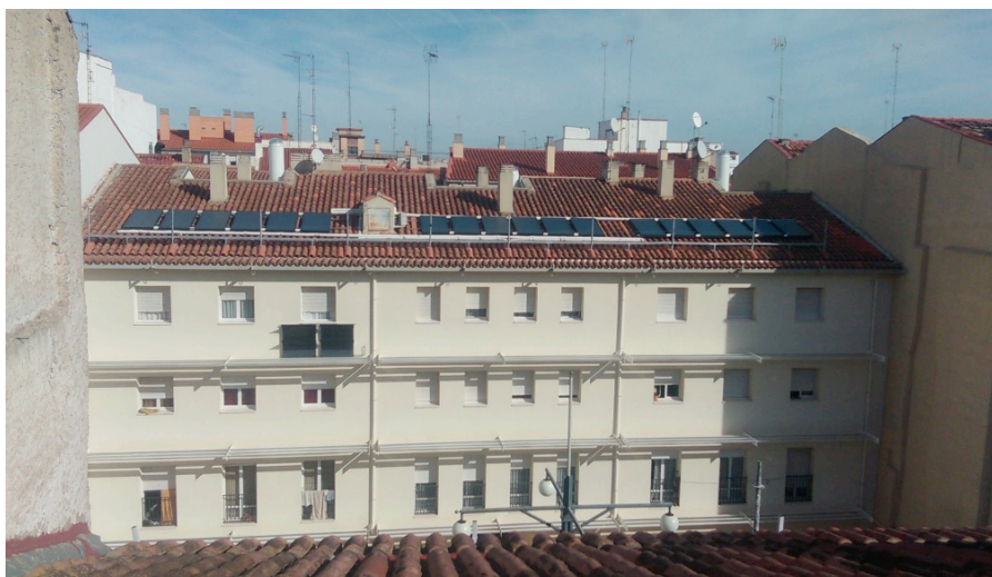
Fig. 7 Edificio A después de la intervención de aislamiento de fachadas, incorporación de protección solar, paneles solares híbridos para ACS y electricidad, conductos solares para iluminación de patios y prototipo de calefacción solar pasiva.
