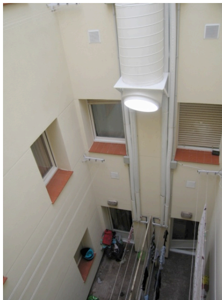
Fig. 6 Patio interior después de la intervención
