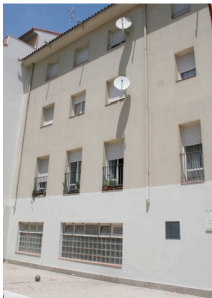
Fig. 3 Fachada sur antes de la intervención. Mediodía de octubre
