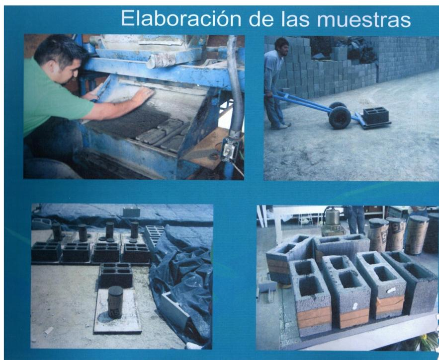
**Fig. 2** Elaboración de muestras del bloque diatérmico cementado.
