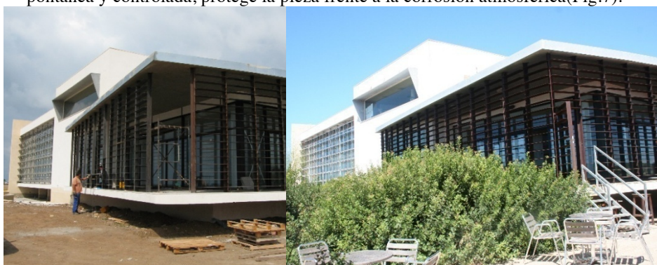
Fig. 7 Empleo de acero corten . La fotografía de la izquierda está tomada durante la ejecución de la obra en 2006. La imagen de la derecha en una visita realizada en agosto 2016
