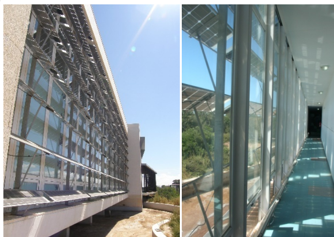
Fig. 9 Paneles solares. Vista desde el interior y exterior del edificio
