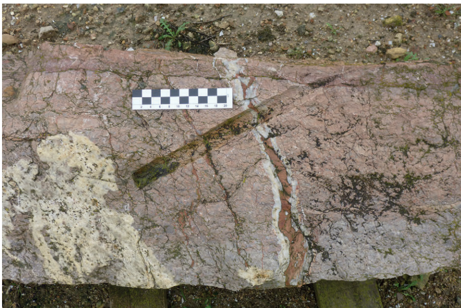
Fig. 4. Fragmento de fuste con cavidad para espiga metálica longitudinal, insertada de forma perpendicular a las vetas del mármol.
