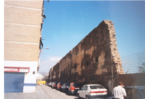
Fig. 6. Detalle del muro que cerraba al Barrio de Huelin hasta mediados de los años 70. Asociación de vecinos Torrijos, 1970 aprox.
