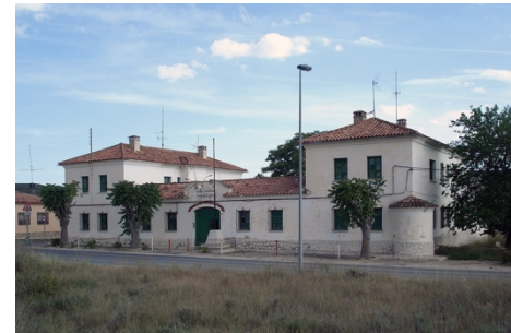
Figura 1. Antigua casa-cuartel de Algueña (Alicante). Fuente: COR & Asociados.
