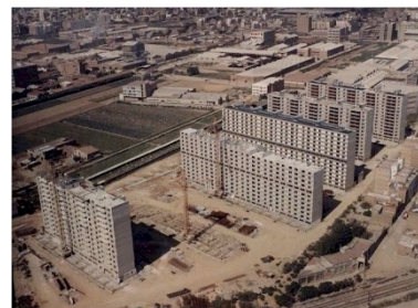
Figura 7. Bellvitge, primeros bloques en construcción, 1968.
